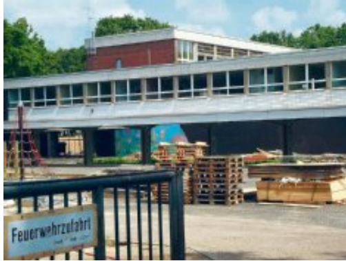
Auf dem ehemaligen Gelände der Förderschule soll das neue Gebäude für eine Gesamtschule entstehen, Foto: Schöneck
